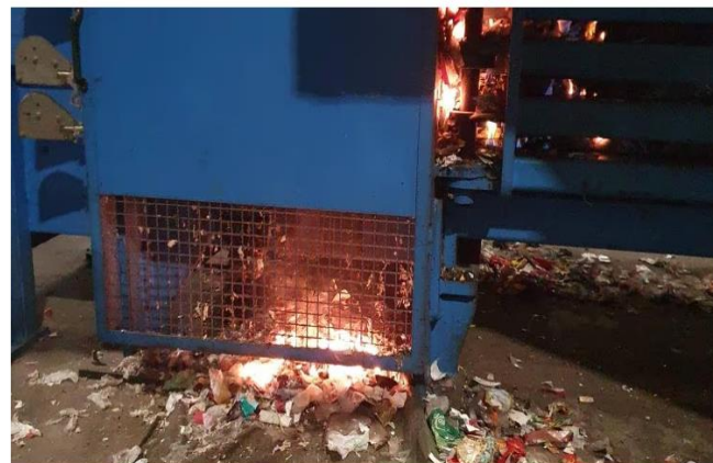
Brann forårsaka av batteri i restavfallet i søppelsorteringsanlegget hos Ivar på Forus mellom Sandnes og Stavanger tidlegare i år. Ingen blei skada i brannen. FOTO: IVAR
